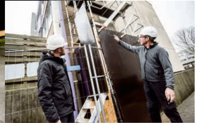
En af Kim Sørensens opgaver er at sætte plader og afskærmning på stilladserne, så områdets børn ikke bruger dem som klatrestativer.
